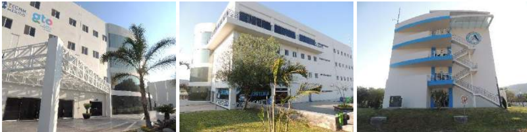
Fotos de avance de obra de la Conclusión de la Construcción de la Unidad Académica Vertical
