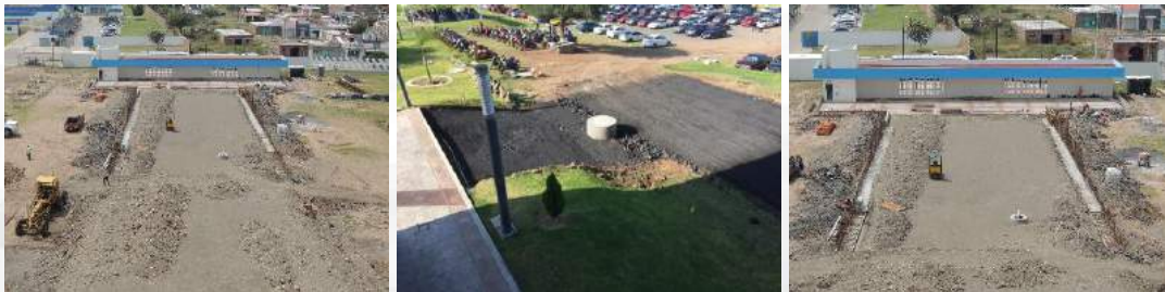
Fotos de la Construcción de la Primera Etapa del Andador Peatonal y Obras Complementarias
